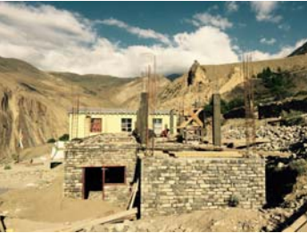
Le chantier avance au rythme
