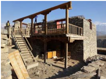
L'internat fissuré et hors d'usage
