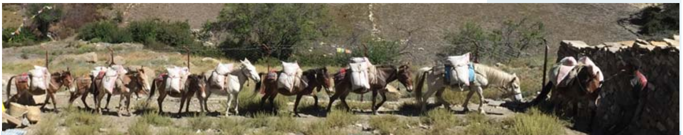
Des mulets et des chevaux apportent les sacs de ciment et de sable pour la construction du nouvel internat.
