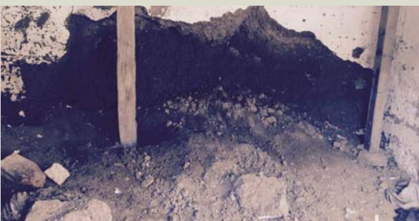
La salle de classe après le séisme : deux murs arrachés, le toit étayé par plusieurs poutres, 4 salles de classes inutilisables,...
